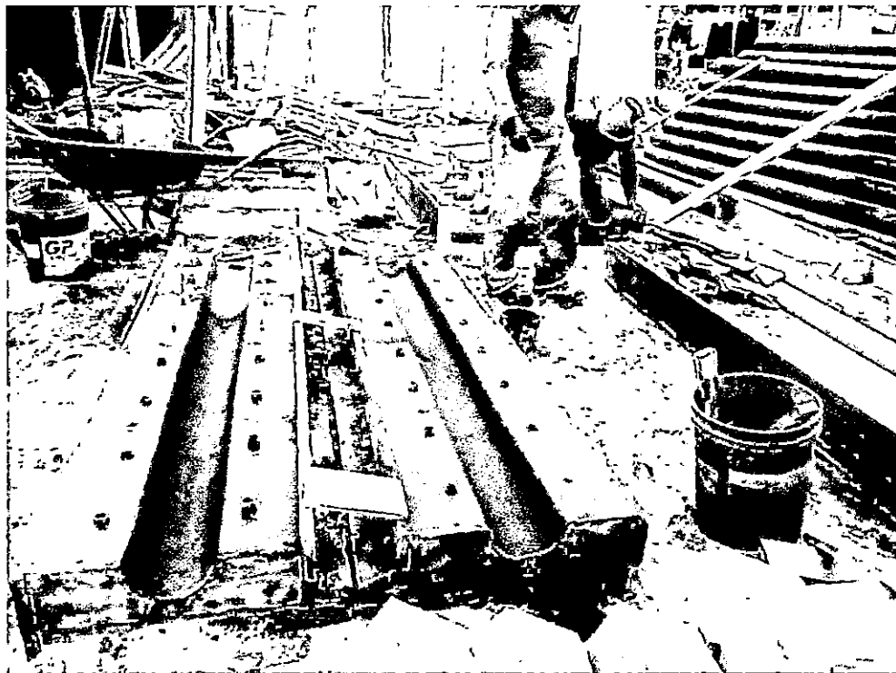
FOTO N° 05: Fabricación de lastres para emisor submarino.
