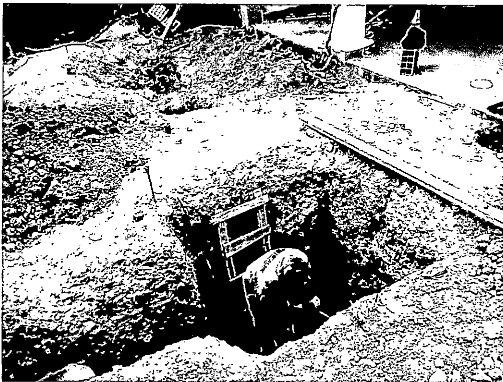
FOTO N° 02: Excavación de cimentación de sub estación eléctrica.
